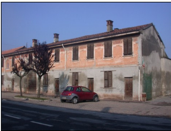
Figura 30. Edificio storico soggetto a risanamento conservativo
